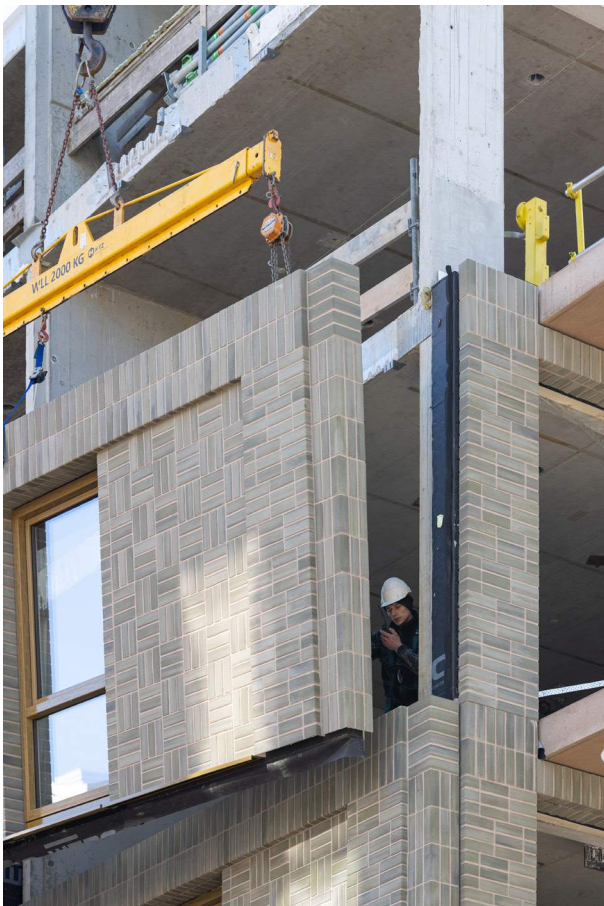
plaatsing prefab gevelelementen (Stijn Poelstra)
